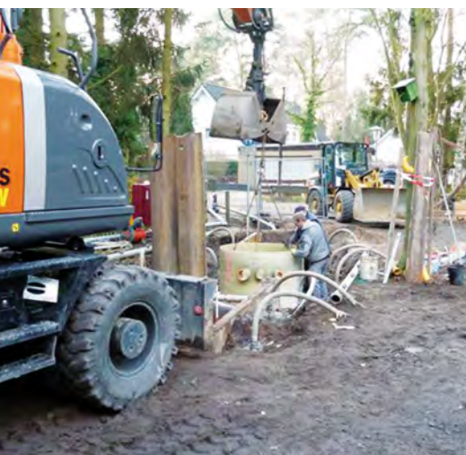
Строительные работы на новой насосной станции
