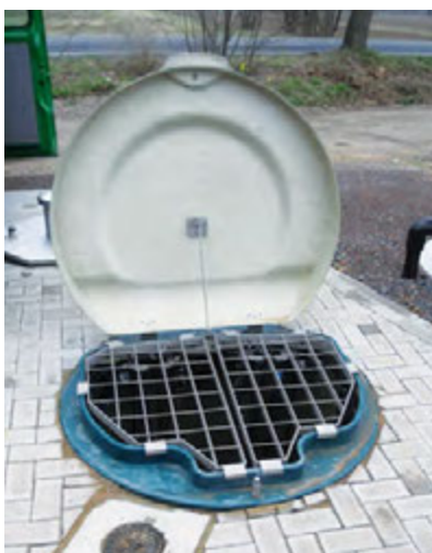
Установка насосных станций подземным способом
