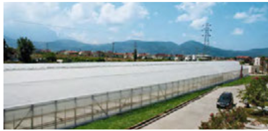
В Фетийе с помощью природного ресурса солнечного света ежегодно высушивается в целом 12 тыс тонн очистных шламов
