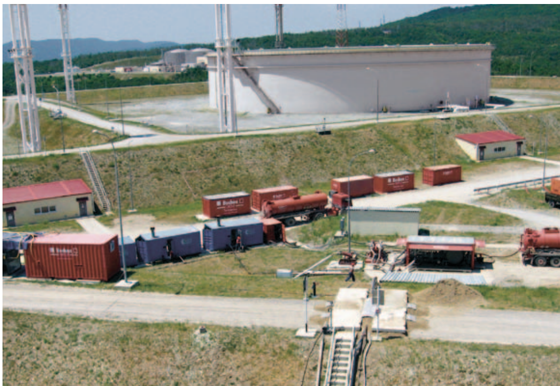
Automatyczne urządzenie do czyszczenia zbiorników firmy Buchen przy czyszczonym zbiorniku z pływającym dachem w Noworosyjsku
