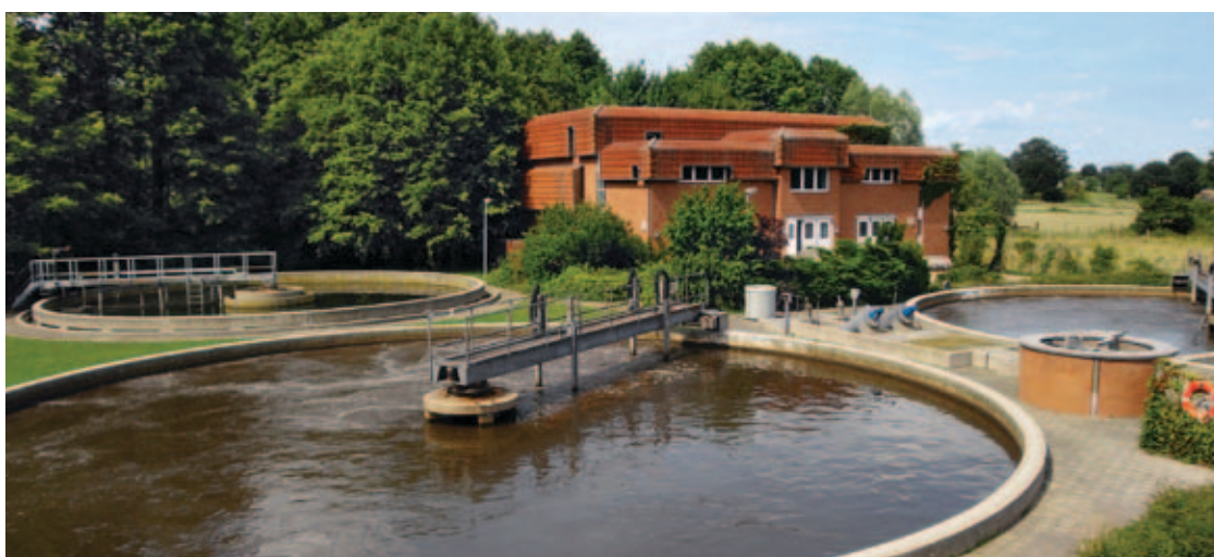
Nowoczesna filtracja na sucho gwarantuje wysoką jakość oczyszczania ścieków
