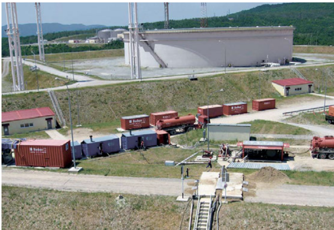
A Buchen automatizált tartálytisztító berendezése a tisztítandó úszótetes tartállynál a novorosszijszki tartályközpontban
