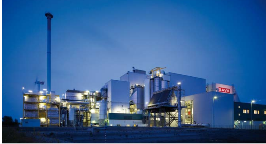
Atık yakma işlemi esnasında fosil yakıt kullanımına gerek yoktur. Ayrıca SAVA, 5.680 mWh değerindeki elektriği kamusal şebekeye aktararak enerji dönüşümüne de katkıda bulunmaktadır
