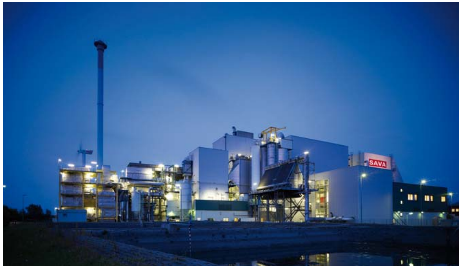
Для сжигания специальных отходов не требуется природных горючих материалов. Наоборот – установка SAVA поставляет 5.680 МВт электроэнергии в систему общественного электроснабжения, что является важным вкладом в дело переориентации энергетической экономики.
